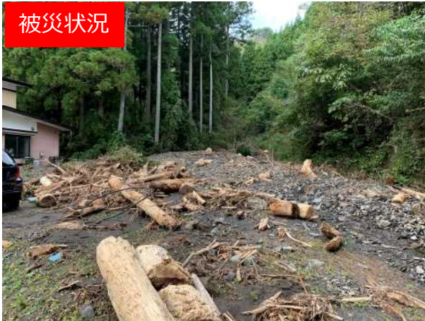
不安定土砂堆積状況
