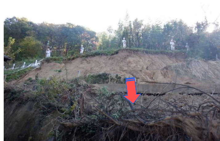
斜面崩壊状況
