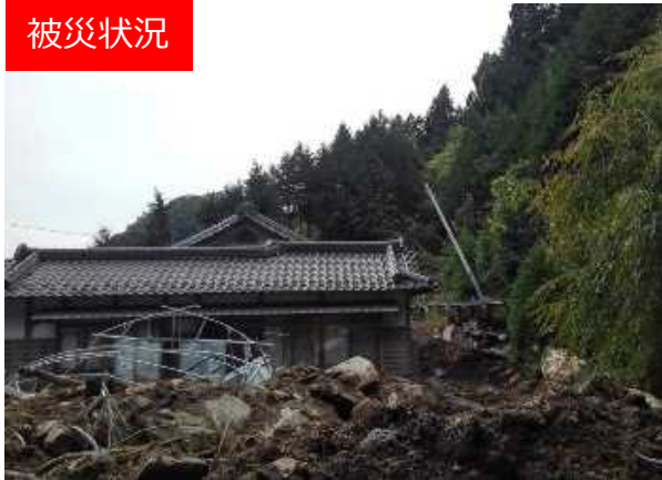
不安定土砂堆積状況
