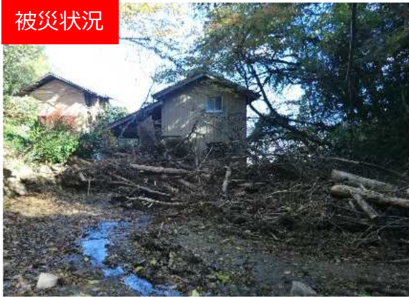
不安定土砂堆積状況
