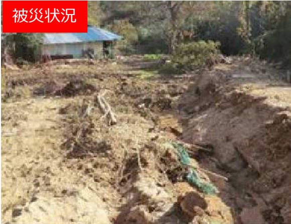
不安定土砂堆積状況
