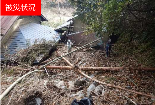
不安定土砂堆積状況
