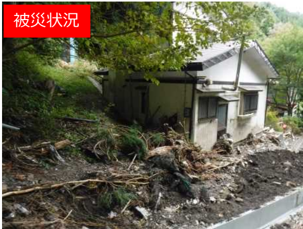
不安定土砂堆積状況
