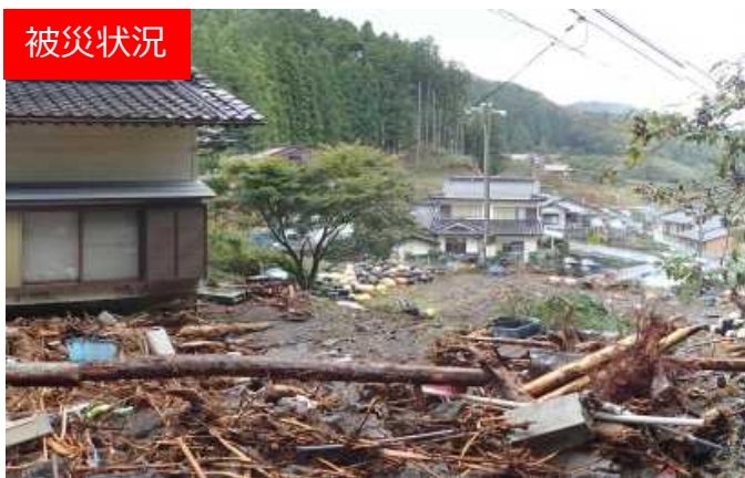
不安定土砂堆積状況
