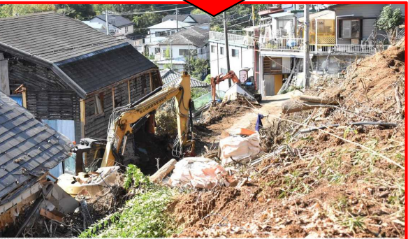
崩壊土砂撤去等の応急対応を実施中
