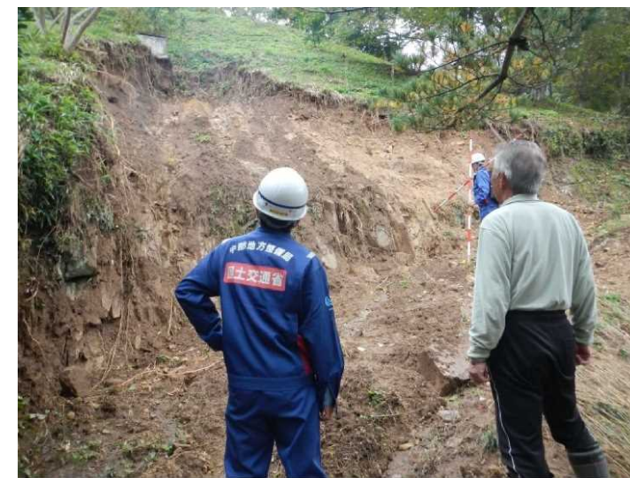
聞き取り調査 【福島県伊達市】 (中部地方整備局)
