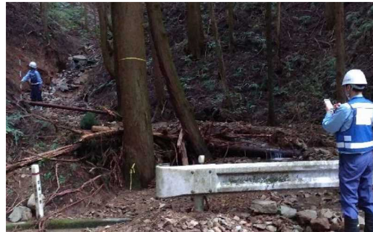
土砂崩落箇所調査 【埼玉県比企郡ときがわ町】 (中国地方整備局)
