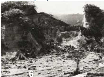
狩野川台風(S33)による被害(伊豆市)
