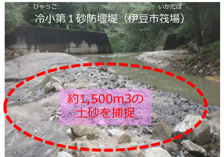
台風第19号豪雨に伴う流出土砂の捕捉状況
