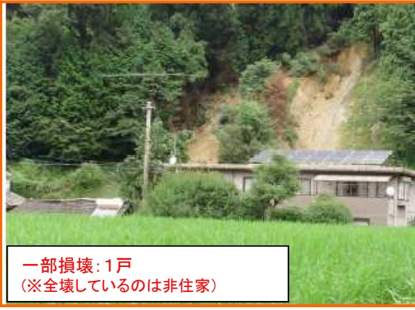
7/21 福岡県飯塚市内野 いいづかし うちの がけ崩れ
