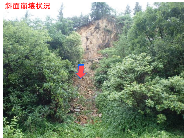
斜面崩壊状況
