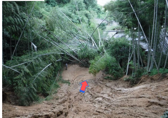
斜面崩壊状況
