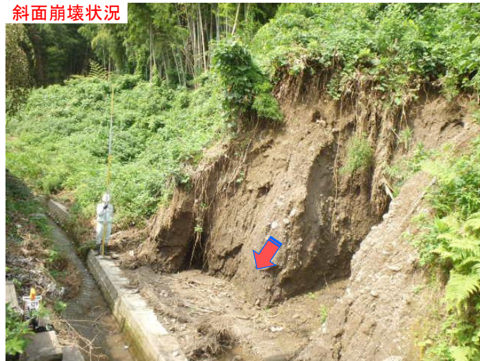
斜面崩壊状況
