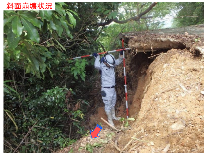
斜面崩壊状況
