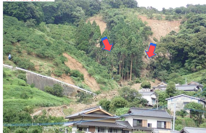
斜面崩壊状況
