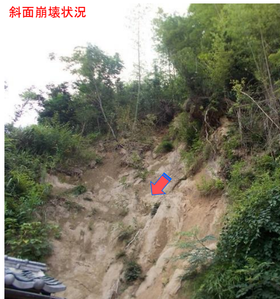
斜面崩壊状況
