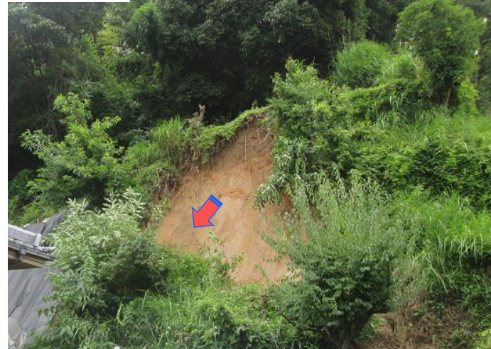
斜面崩壊状況
