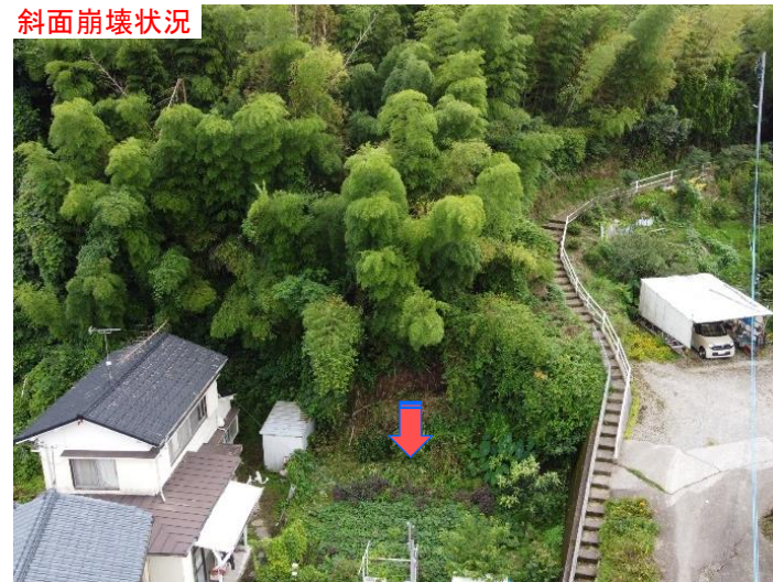
斜面崩壊状況
