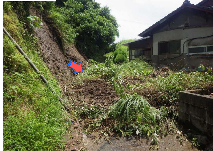
斜面崩壊状況
