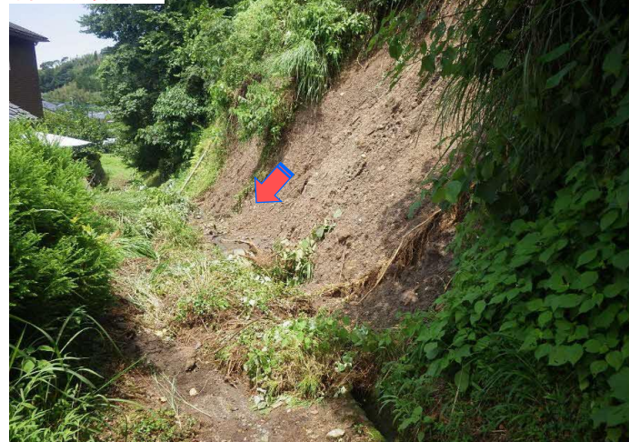
斜面崩壊状況
