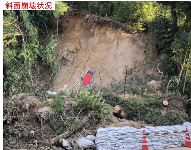
斜面崩壊状況
