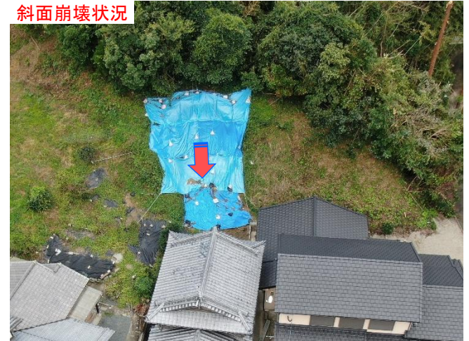
斜面崩壊状況
