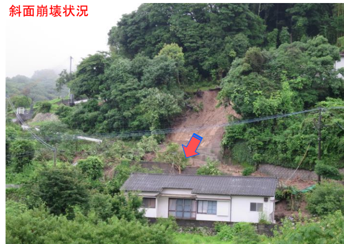
斜面崩壊状況
