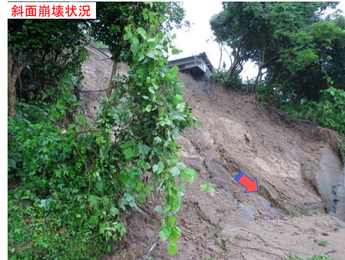
斜面崩壊状況
