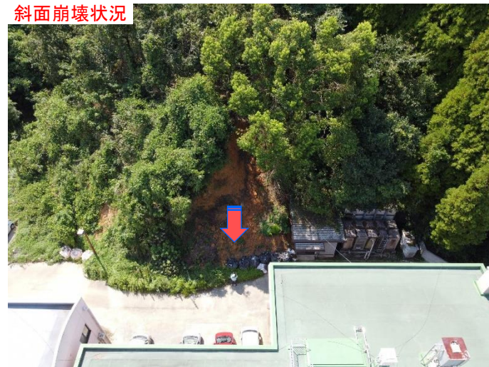
斜面崩壊状況
