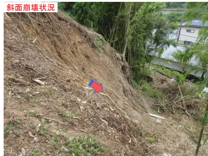
斜面崩壊状況
