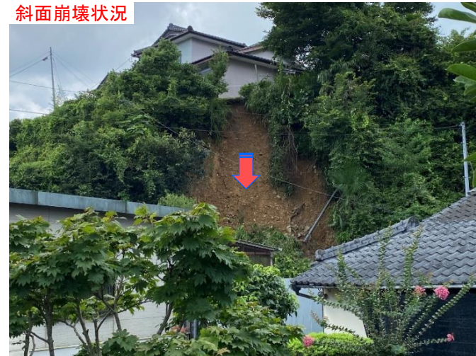
斜面崩壊状況
