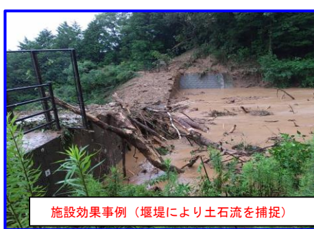
7/6 土石流等 ひろしま にしく いのくちだい 広島県広島市西区井口台3丁目
