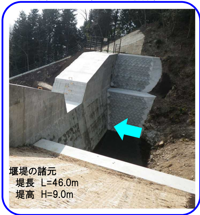
土石流発生前 (H29.3撮影)
