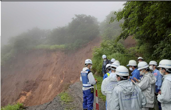
土石流災害専門家による調査状況(7/4)
