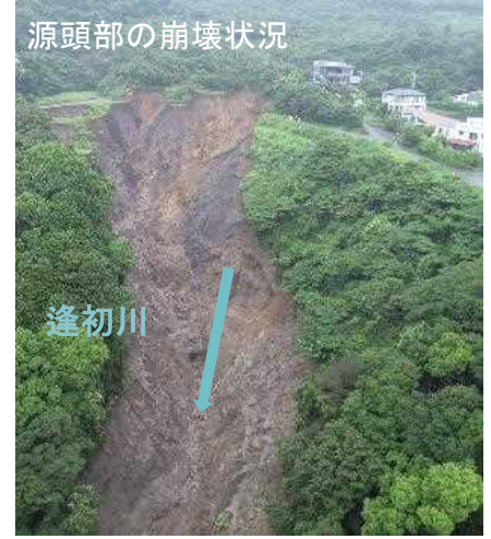
【土石流による被害状況等】
