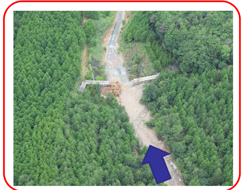
土石流発生直後 (R3.8.15)
