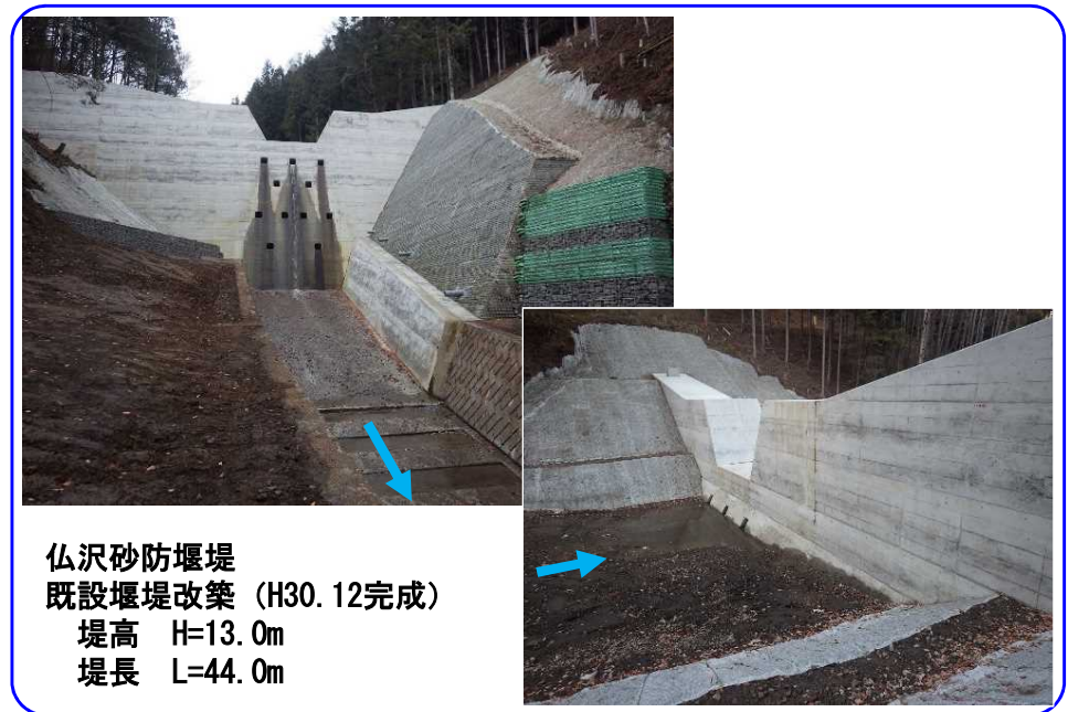
土石流発生前 (H30.12撮影)
