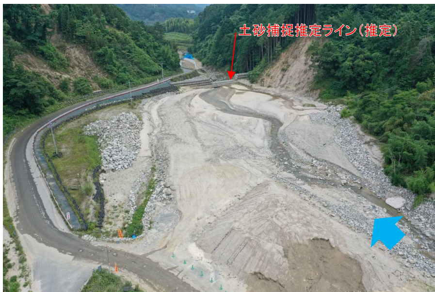
土砂捕捉前 (R3.6.30撮影)
