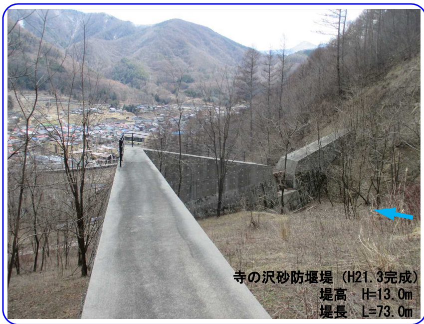
土石流発生前 (H31.4.12撮影)
