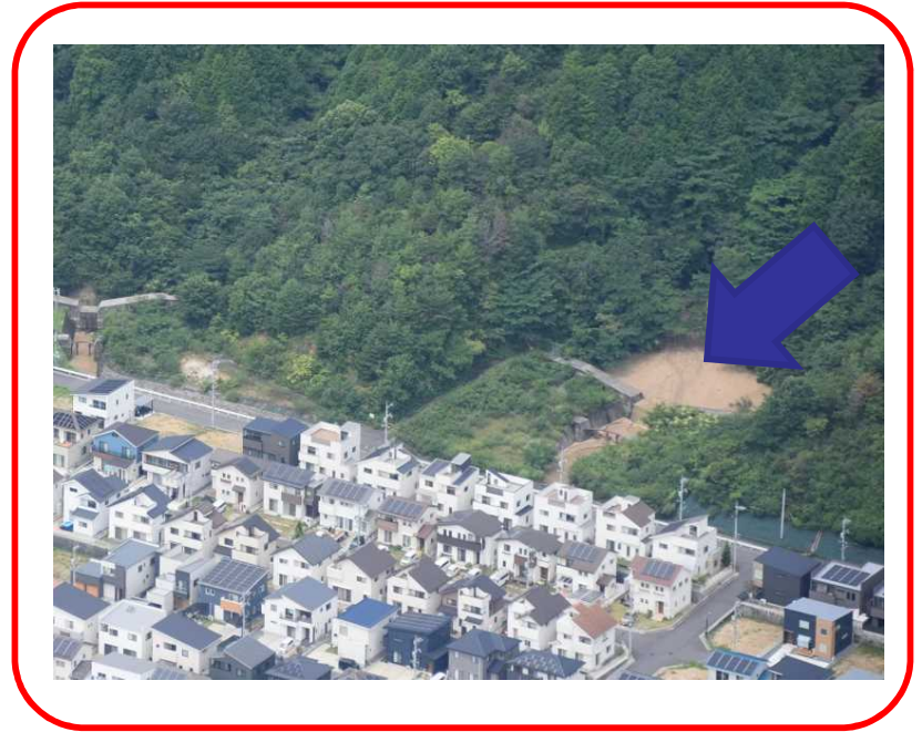
土石流発生直後 (R3.8.15)
