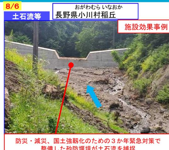
防災・減災、国土強靱化のための3か年緊急対策で整備した砂防堰堤が土石流を捕捉
