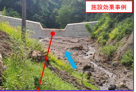
防災・減災、国土強靱化のための3か年緊急対策で整備した砂防堰堤が土石流を捕捉
