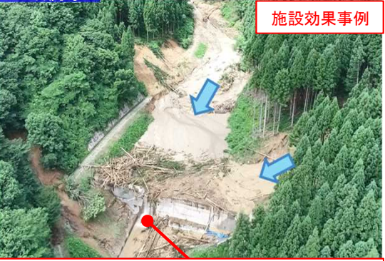
砂防堰堤が土石流を捕捉
