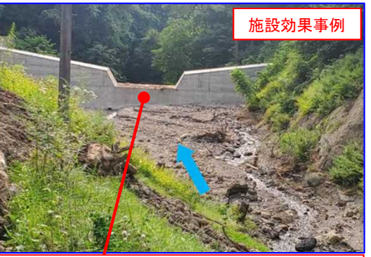
防災・減災、国土強靱化のための3か年緊急対策で整備した砂防堰堤が土石流を捕捉
