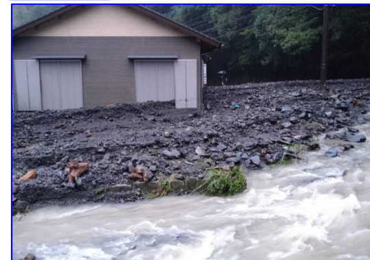
9/19 がけ崩れ 宮崎県日之影町七折
