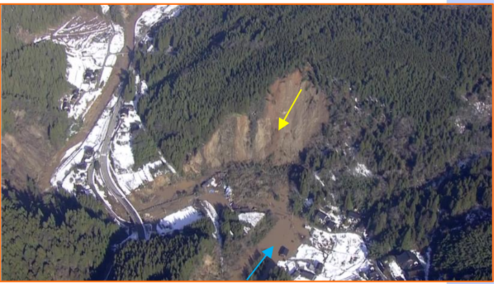
わじまし くまのまち ①石川県輪島市熊野町
