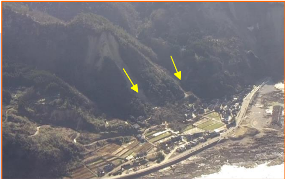
すずし にえまち ③石川県珠洲市仁江町 【道の駅すず塩田村の西側】
