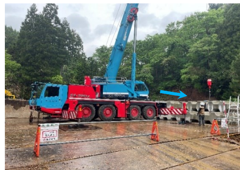
応急対策工事状況（寺地川） ブロック堰堤設置
