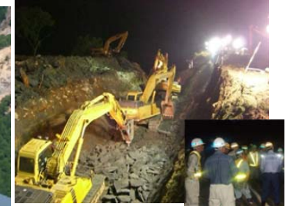
24時間体制での応急工事
