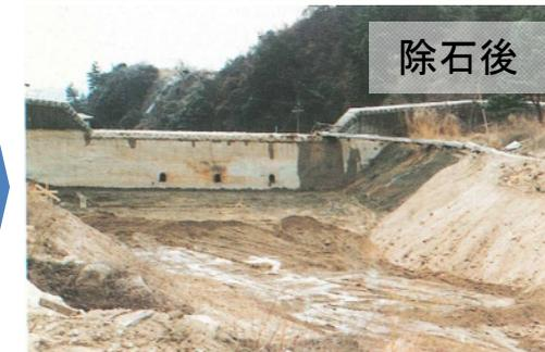
緊急時に既設堰堤を除石することにより、応急的に土砂の捕捉容量を確保。
