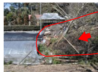
地すべりブロック末端部状況
