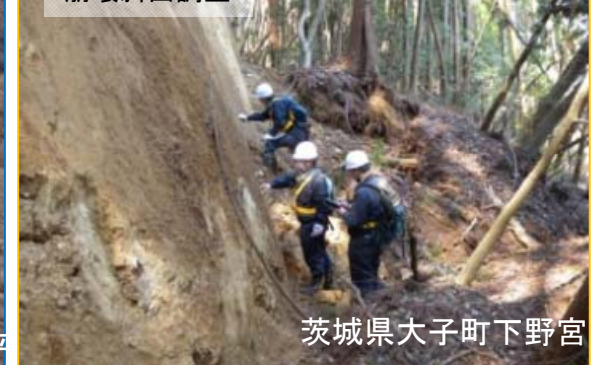
崩壊斜面調査
