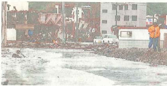
岸壁を越え、道路に流れ込む海水。地盤が下がった被災地では、大雨による二次災害が懸念される（29日、宮城県女川町）
