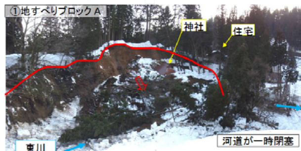
十日町市大畑地区地すべりの崩壊状況
