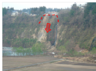
津南町正面地区宅地に及んだ急傾斜地の崩壊
