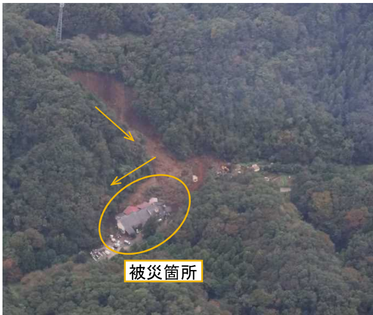
崩壊箇所全景
