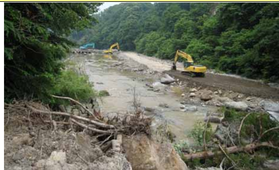
河道掘削実施中
