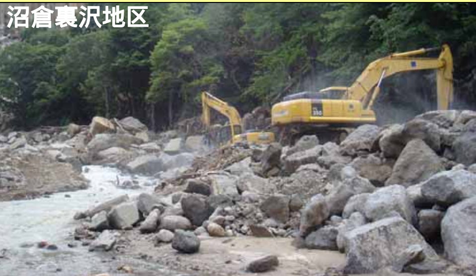
河道掘削実施中
