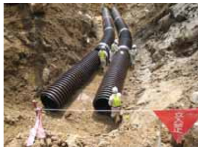
仮排水路管敷設状況
