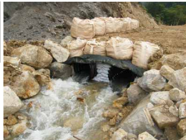
仮排水路管吐口の状況
