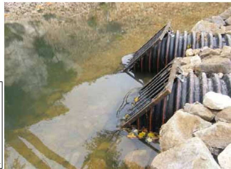
仮排水路管呑口の状況
