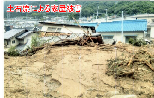
写真① 畑賀川合流点付近での土石流被災状況 出典: 土砂災害ポータルひろしま
