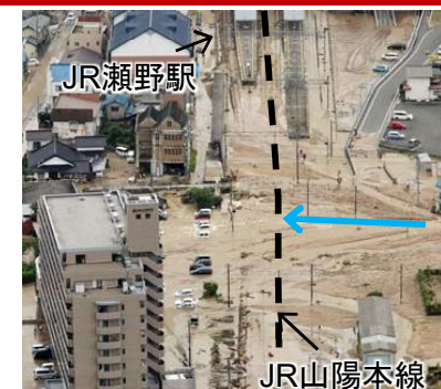
榎ノ山川の被害状況
