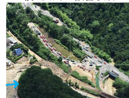
大元谷川の被害状況
