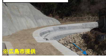
榎ノ山川の護岸整備
