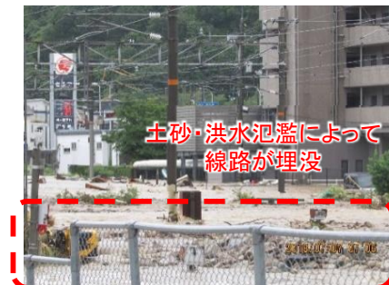
写真③ 瀬野駅付近のJR山陽本線途絶の様子 出典: 安芸区瀬野学区自主防災会 提供
