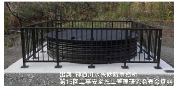
地すべり対策施設の景観配慮事例(集水井及び立ち入り防止柵を環境色に塗装)
