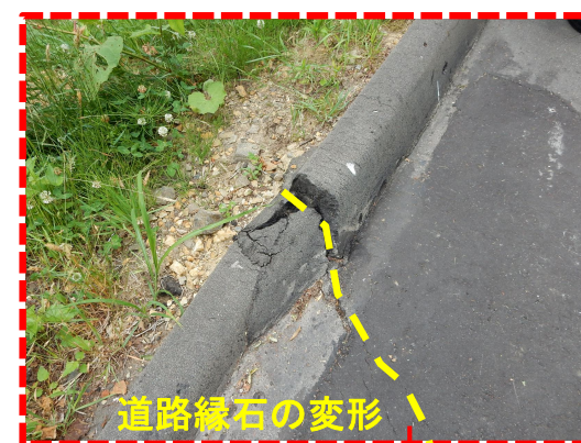
ブロック境界部の路面の亀裂・沈下、縁石の変形 手稲橋左岸側歩道の亀裂・沈下
