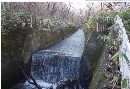
上図：砂防堰堤(軽川) 左図：護岸工(軽川)
